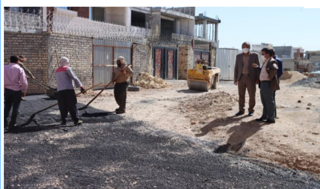
زیر سازی، ترمیم ترانسه ها و لکه گیری آسفالت معابر سطح شهر
