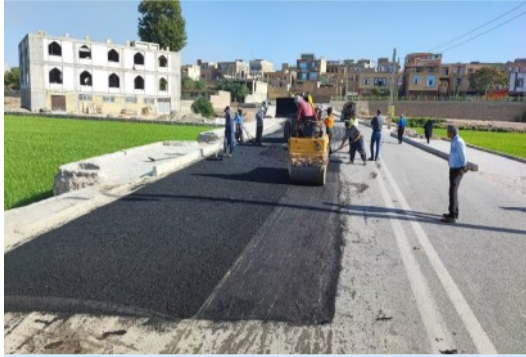
اجرای عملیات آسفالت جاده کشاورز
