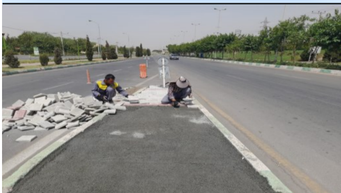
اجرای بلوک فرش تقاطع ها بلوار جانبازان فبه منظور زیبایی
