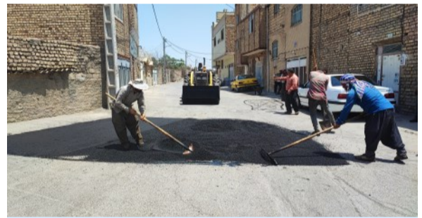
ترمیم ترانسه ها
