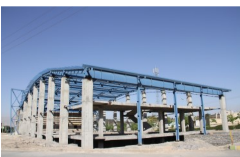
ساختمان استخر قبل
