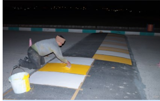
رنگ آمیزی ترافیکی سرعته‌گاه
