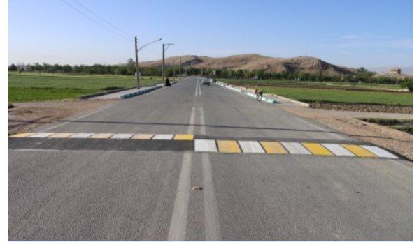
اجرا و رنگ آمیزی سرعت گاه آسفالتی
