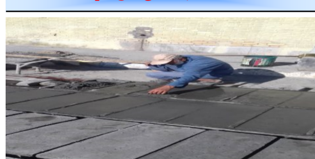
بتن ریزی سنگ لحد
