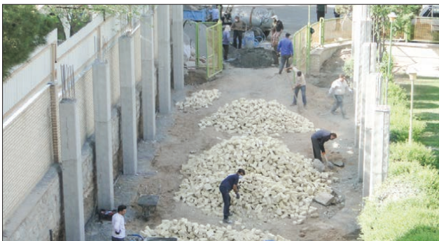
اجرای عملیات ساختمان اورژانس ۱۱۵
