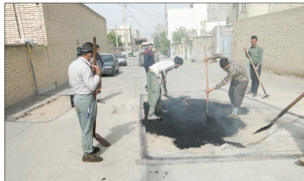
اجرای عملیات لکه گیری و ترمیم آسفالت
