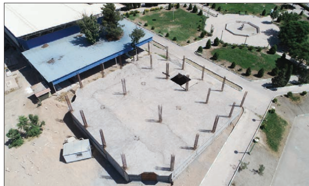
ادامه احداث ساختمان چند منظوره گلستان شهدا در سه طبقه با مساحت ۸۱۰۰۰ متر مربع
