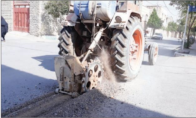
کاترزی جهت نصب لوله آبرسانی
