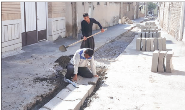
اجرای کانپو جهت دفع آب‌های سطحی
