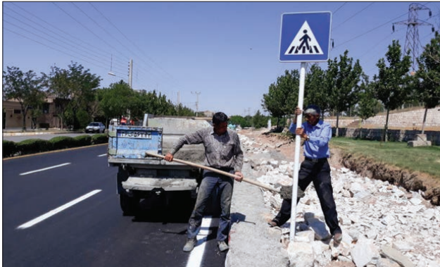
ترمیم و نصب تابلو معابر و علائم ترافیکی
