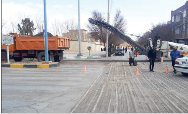
تراش آسفالت معابر جهت ترمیم و روکش مجدد
